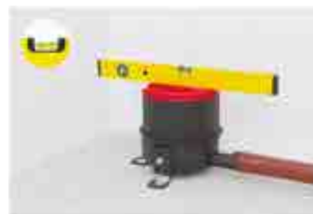
6. Połączyć z rurą odpływową i ustawić spadek rury poprzez regulację uchwytami montażowymi i wypoziomować
